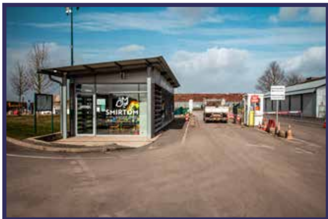
Un centre de recyclage, une plate-forme de compostage
